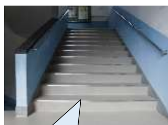
階段すべり止め等の 修繕・張替え
