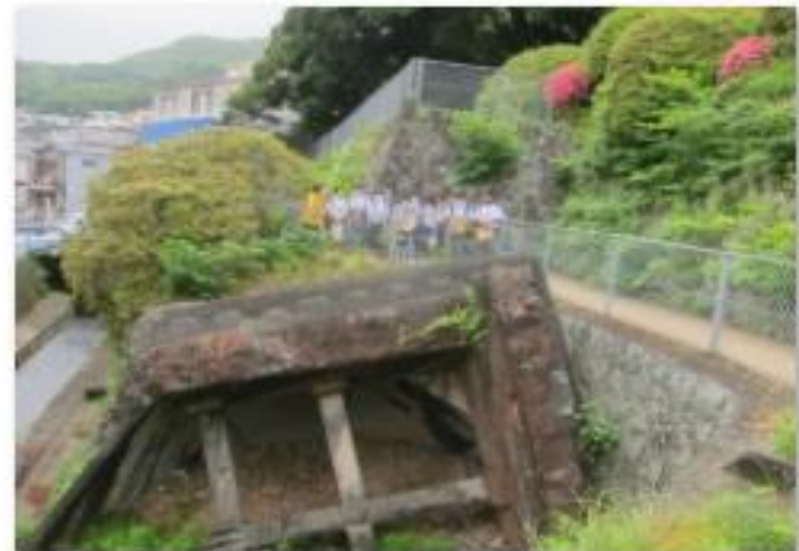
4 破壊された浦上天主堂の鐘楼
